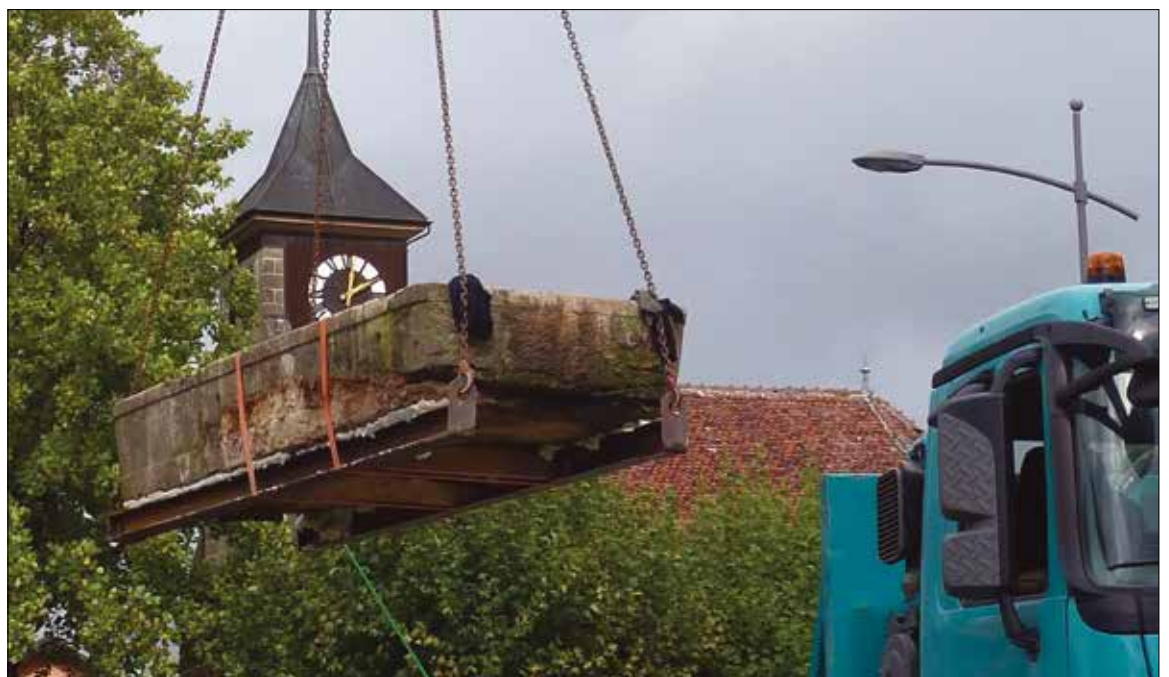
La fontaine de 1816, pesant quelque 4 tonnes, s'envole en attendant une possible rénovation. (Photo Dominique Reymond)
